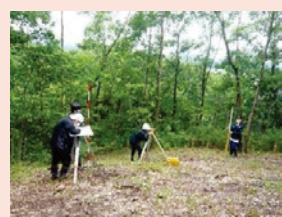
第3図 測量調査の様子
